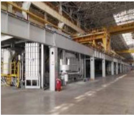
Hidráulico de inclinação de gás de aquecimento de forno
